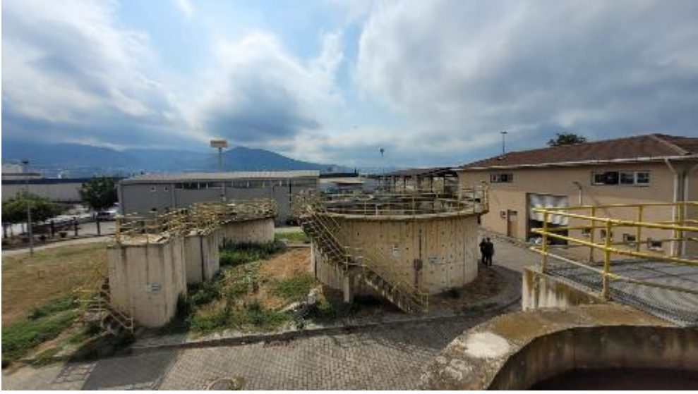
Şekil 2-2 : Atıksu Arıtma Tesisine Genel Bakış
